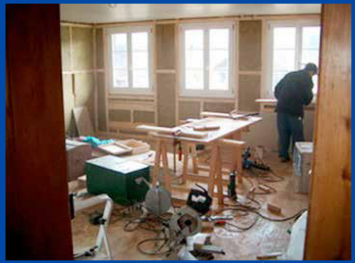
Umbau und Isolation zum heutigen Schlafzimmer 2004
