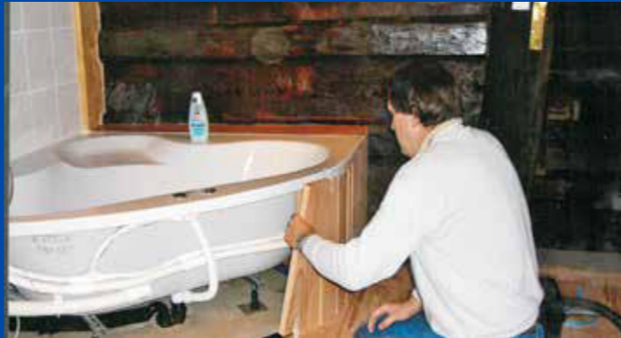
Viel Eigenleistung steckt in dem Haus: Erstellen eines Badezimmers im Anbau
