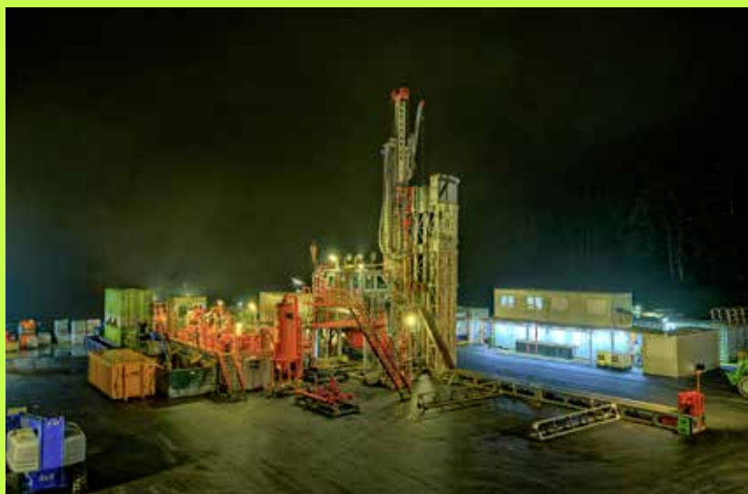
Beleuchteter Bohrplatz beim Hasliboden
