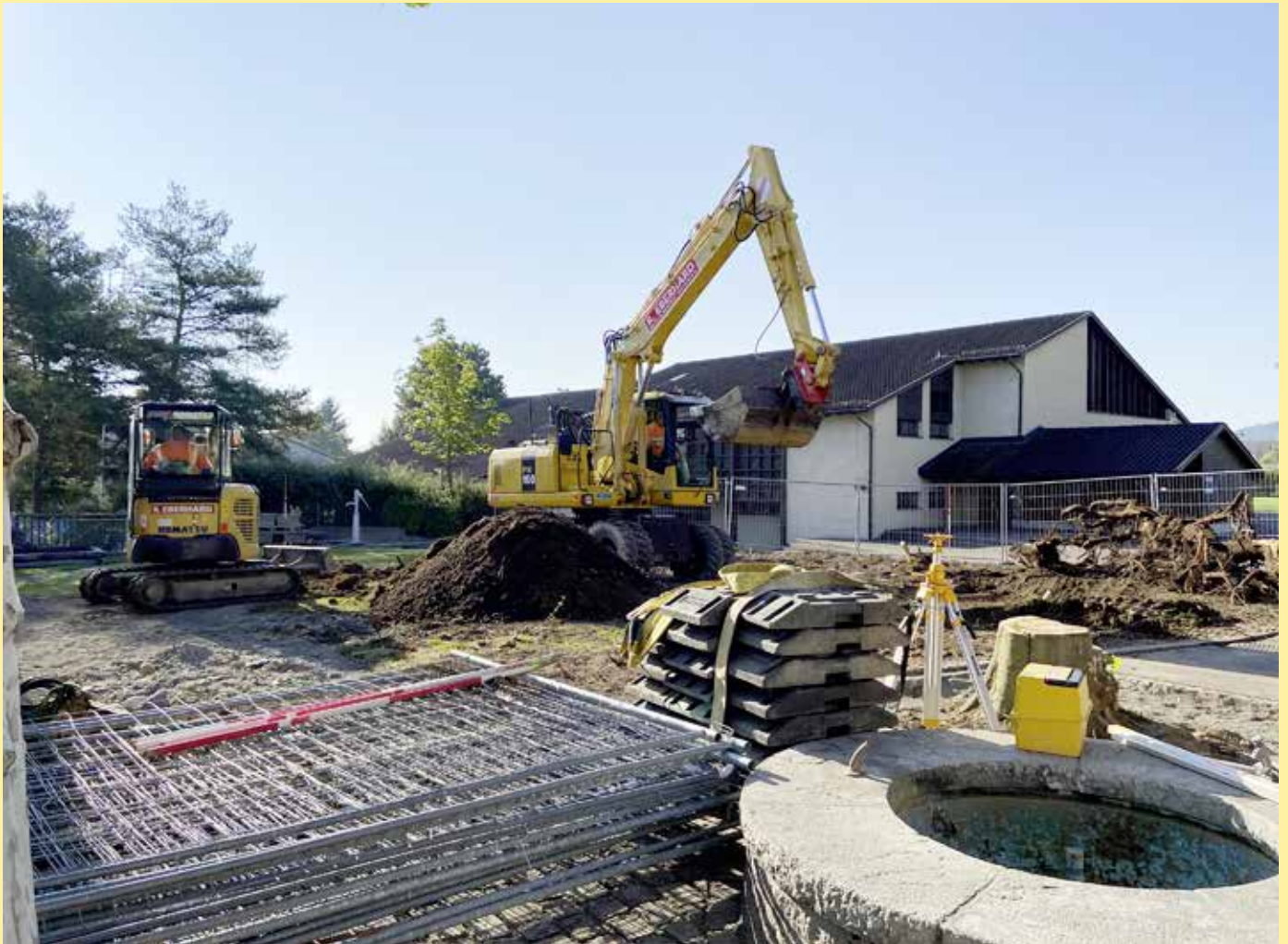
Aushub zum Schulhausanbau 2021
