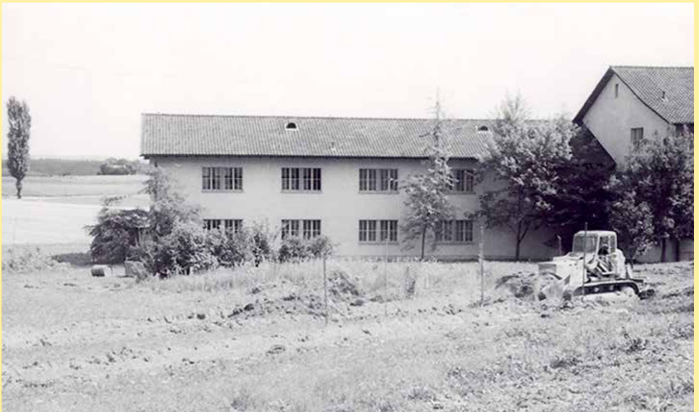
Aushub zum Oberstufenschulhaus 1964
