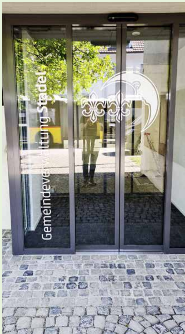
Glasschiebetüren beim Eingang
