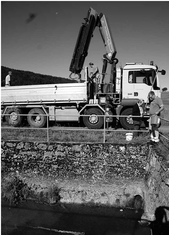
Ausbaggern des Sandfangs im Schleumet, Mai 2018
