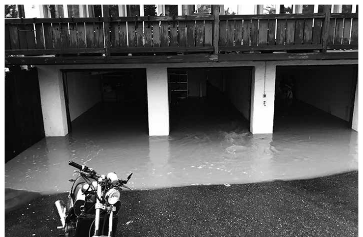
2018: überschwemmte Felder und Garagen in Windlach
