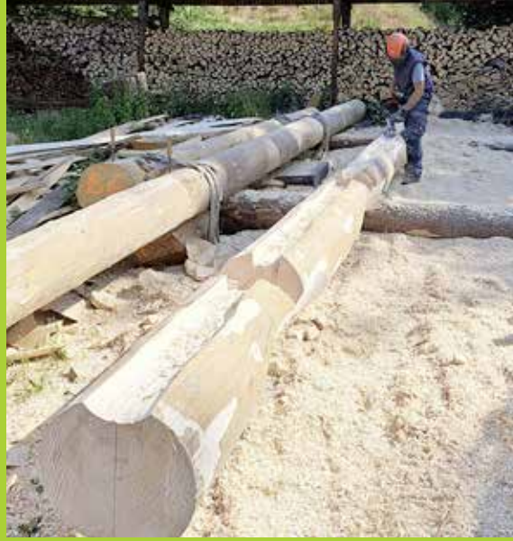
Die Blockhütte wurde bei der Schreinerei Thomas Meier in der Flüenen in Bachs vorbereitet und auf einem Podest aufgebaut. Dann erfolgte der Transport ins Sali, wo die Hütte definitiv aufgestellt wurde.
