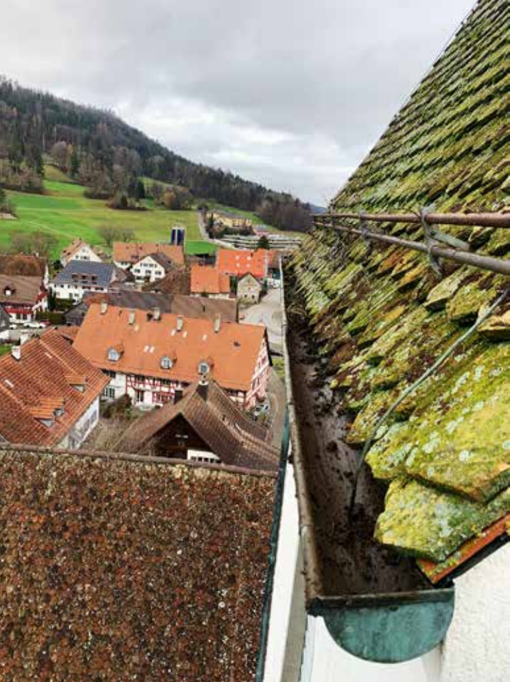
Neben der Nestpflege wurden auch defekte Ziegel ersetzt und die Regenrinnen gereinigt.
