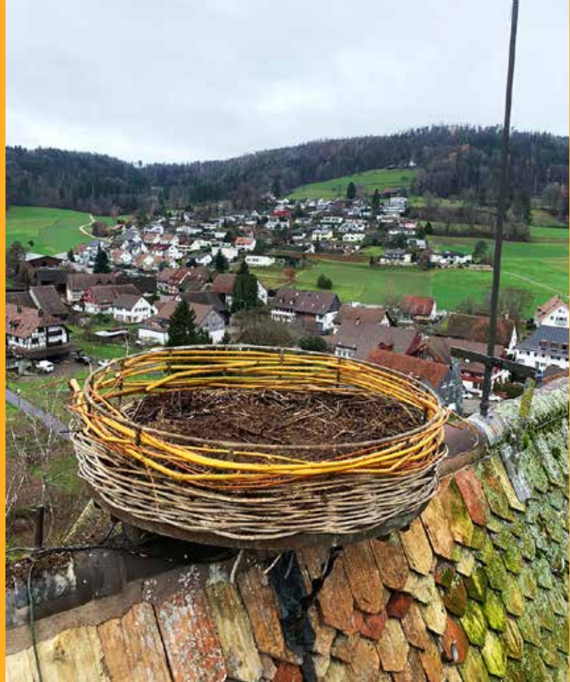
Frisch ausgestattete Wohnung! Ob die Störche die Renovation ihres Sitzes akzeptieren und schätzen ...?
